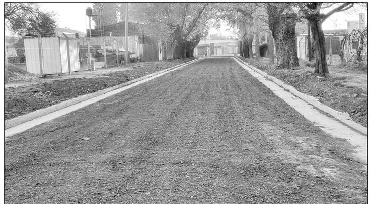
El área de Obras y Servicios Públicos dio por concluida la tarea de la construcción del cordón cuneta en el Barrio Don Pino, trabajo que finalizó con el reacondicionamiento y nivelación de la calzada, tras el movimiento de
