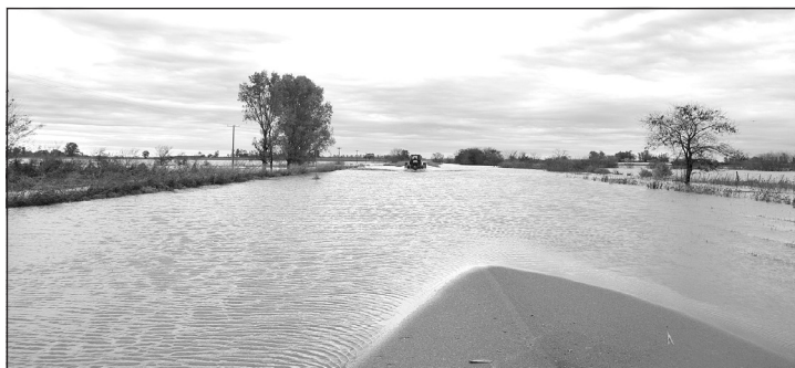
En la Ruta 45, el agua sobrepasó el puente Hardoy.
